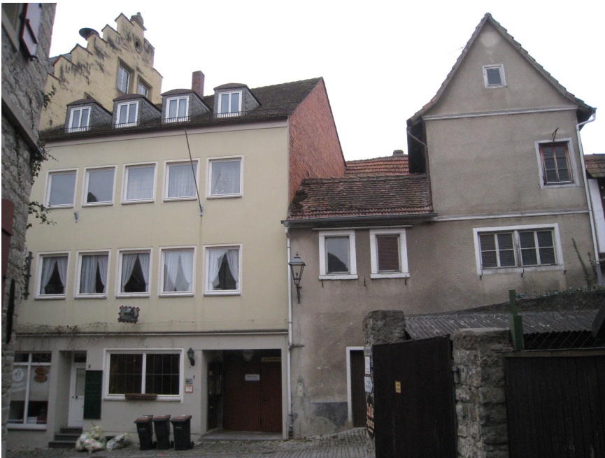
Sanierungsschwerpunkt Bereich hinterm Rathaus / Langengasse
