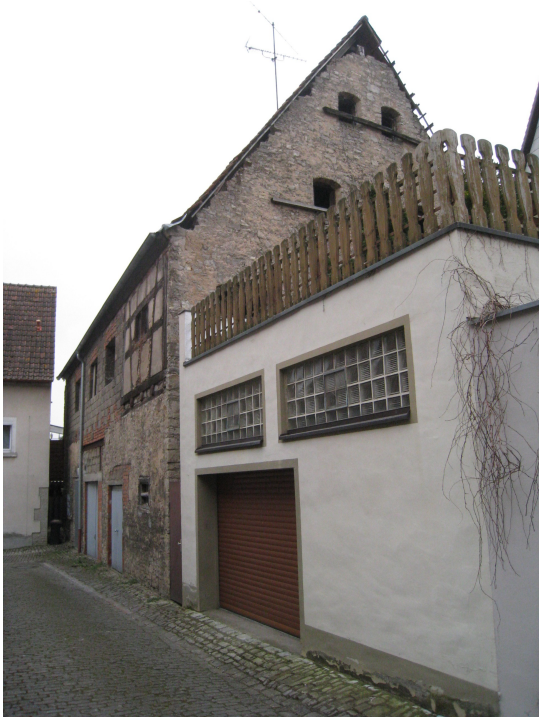
Sanierungsschwerpunkt Eselshof I
