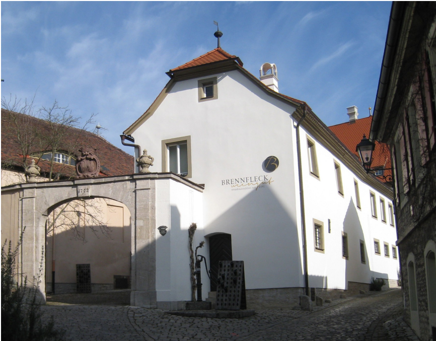
Vorbildlich saniertes denkmalgeschütztes Weingut
